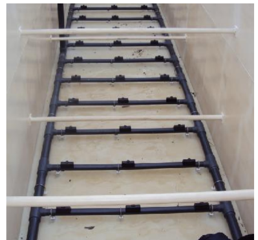
Δίκτυο αερισμού εξισορρόπησης
