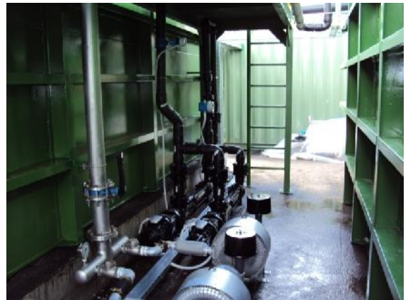
Μονάδα Προεπεξεργασίας (Εσχάρωση – Αμμοσυλλέκτης – Λιπосуλλέκτης)
